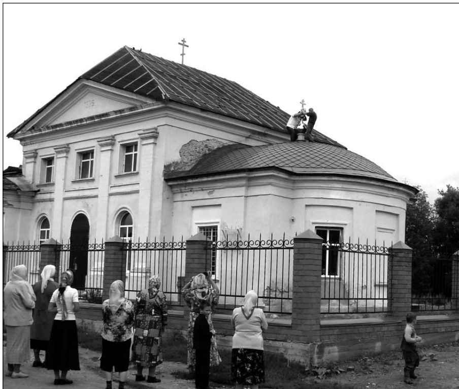
Установка креста над алтарной частью.
